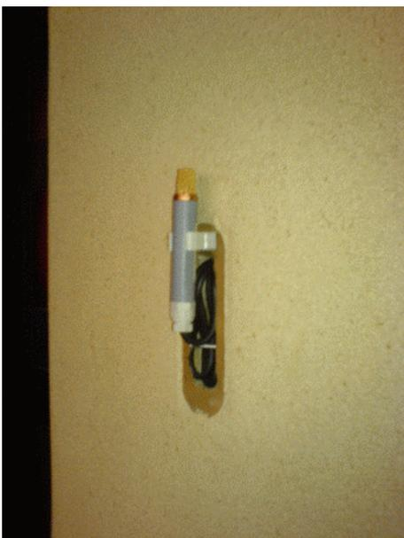
Figur 16: Temperatur- und Feuchtefühler.
