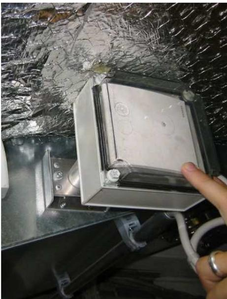
*Figur 8: CO<sub>2</sub>-Fühler im Abluftkanal.*
