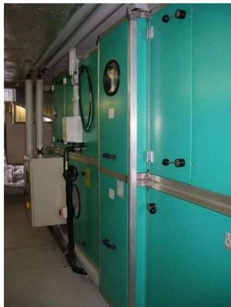
*Figur 9: Monobloc im Technikraum der Aula. Heizung und Kühlung der Aula erfolgt über die Zuluft.*
