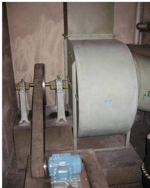
Figur 4: Der Zuluftventilator.
